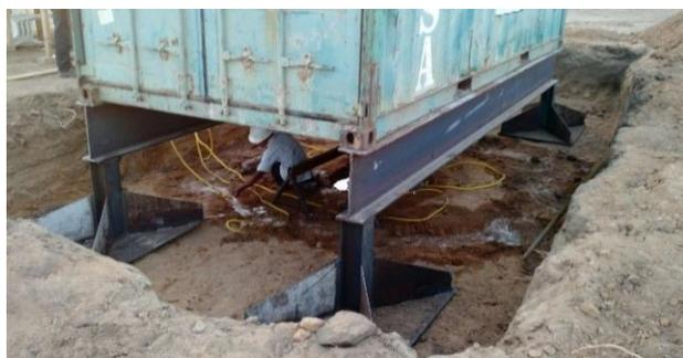
Figura 6. Processo de inundação das estacas de areia e região de contorno da placa.
